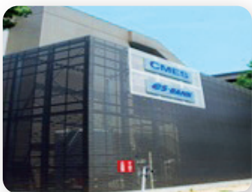
『世界が注目する沿岸環境研究のメッカ』 沿岸環境科学研究センター 写真は生物環境試料バンク
