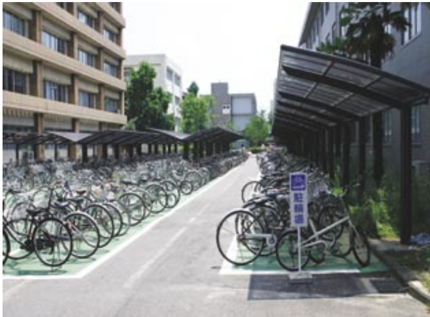
総合研究棟2北側（整備後）
