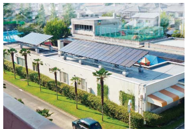
附属幼稚園の太陽光パネル
