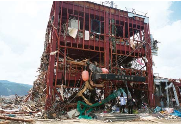
被災した南三陸町の防災対策庁舎
