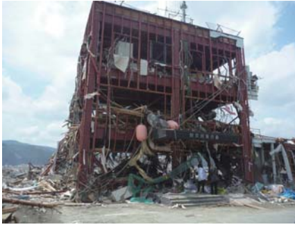
東日本大震災津波により被災した 南三陸町防災対策庁舎
