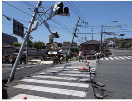
熊本地震による益城町の被災状況
