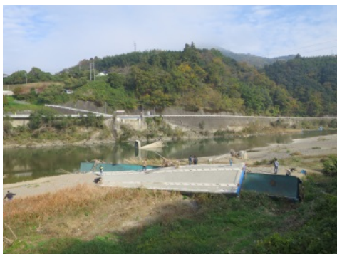
写真 3.3-7 崩落した大成橋を視察
