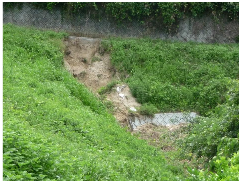
水路が左に曲がる少し手前で崩落
