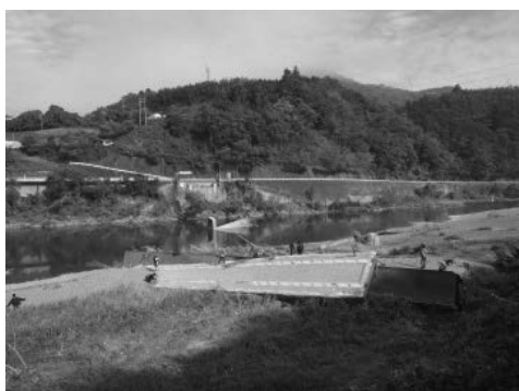
写真 3.3-7 崩落した大成橋を視察
