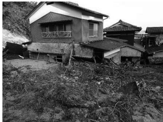
写真 5.3.2-4 高浜 5 丁目の土砂災害
