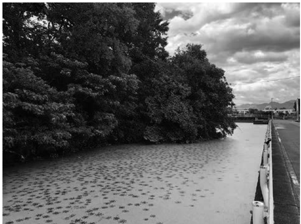
写真 3.2.1-2 松山市荏原城跡被害状況
