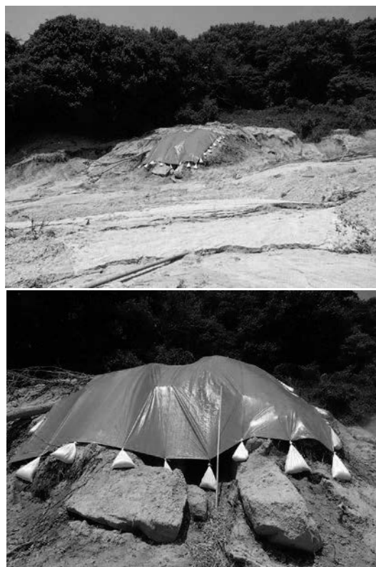
写真 3.2.1-1 松山市難波奥谷古墳被害状況
