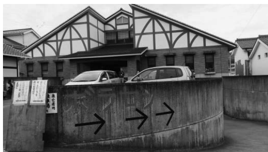
写真 3.3-13 ボランティアセンター
