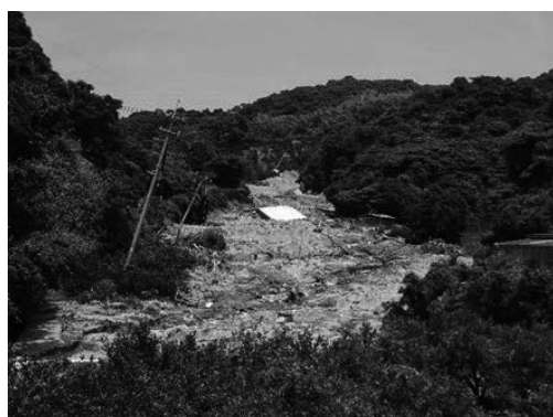
写真 5.3.2-1 高浜6丁目先の土砂災害
