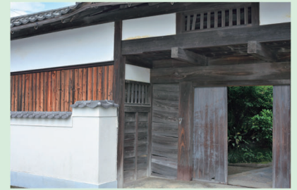
長谷部映門屋敷の長屋門
