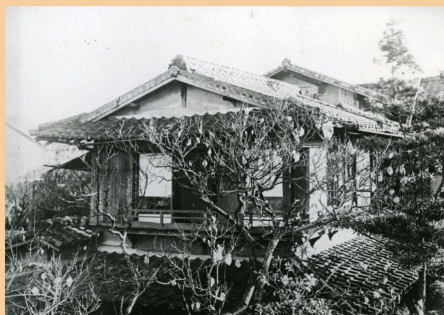
焼失前の愚陀仏庵2階 (年代不明)
